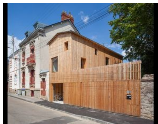
Figure 8. Façade plus fermée sur rue - Nantes
