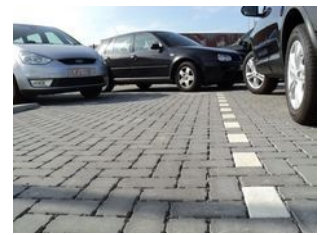
Figure 41. Exemple de pavage réalisé sur lit de sable
