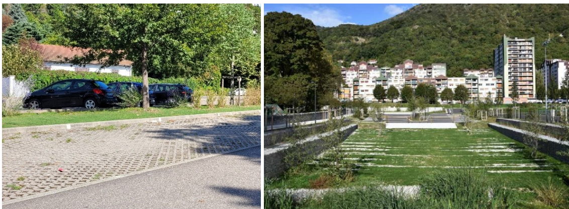
A gauche, stationnements perméables sur la commune de Voiron (38) et à droite, jardin de pluie et bassin de rétention sur la commune de Voreppe (38)
