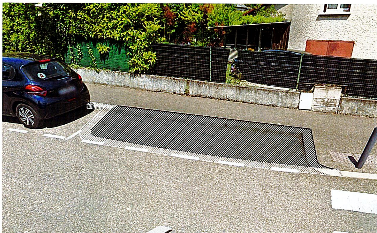
Vue des aménagements objet de la permission de voirie
